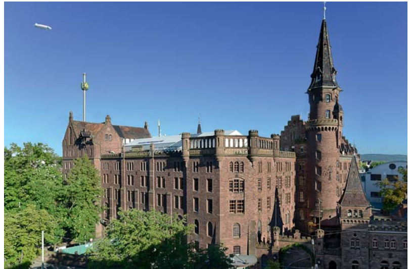
Bild 3: Die Hoepfner-Burg. © Ras Rotter
